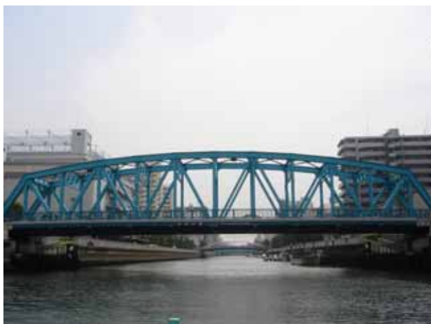
図3 - 24 西深川橋(小名木川)
