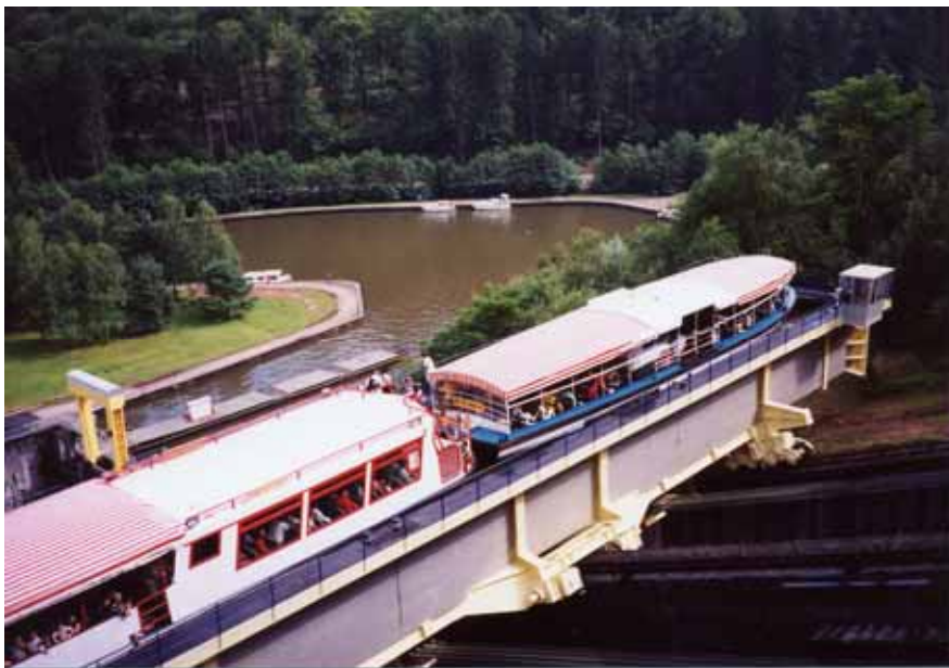
図2 - 27 サンルイアルツピエにある斜面エレベータ
