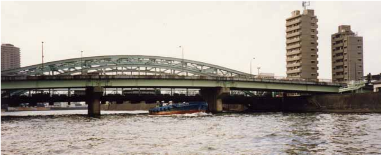
図2 - 8 千住大橋を航行する油タンカー
