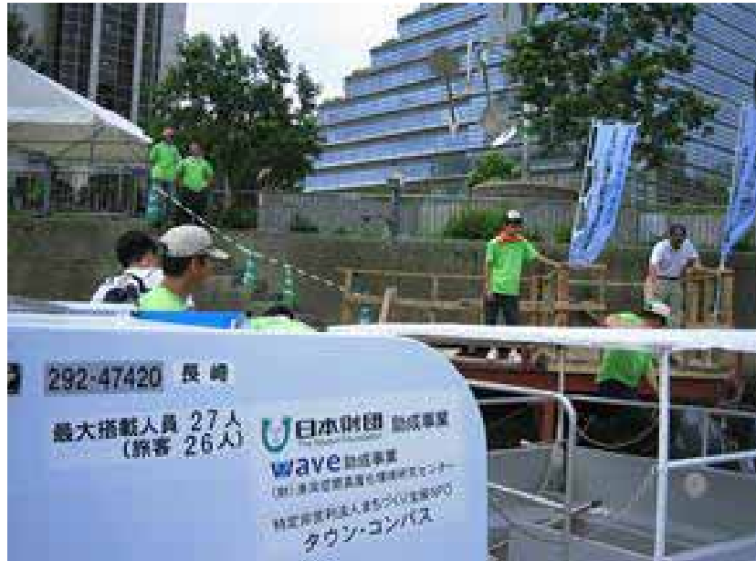
図2 - 20 水上公園における仮設栈橋の状況(タウンコンパスのホームページによる)
