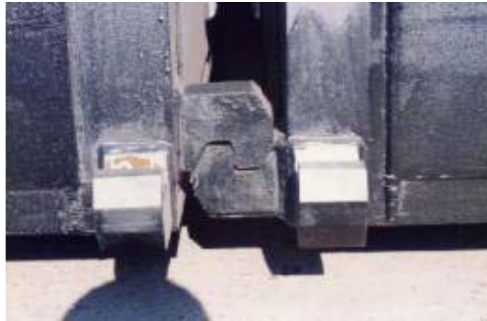
鍵型連結部 (長手、横手両方向の接続に可能)
