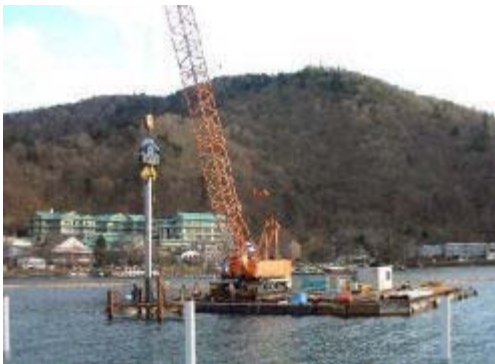
杭打台船(パイプロ使用)
