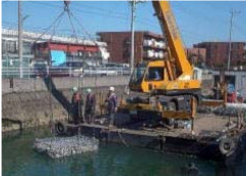
10t 吊ラフタークレーン台船
