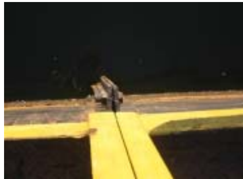
チアワフェリーボンツーン側面フランジ結合
