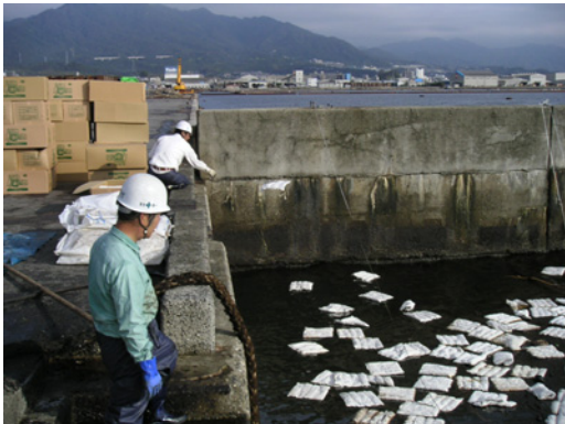
写真－VI. 1. 3 杉樹皮製油吸着材（マット型）の投入
