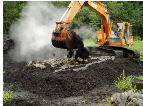
写真－Ⅵ． 2． 2 バーク堆肥で 油吸着材を被覆する様子
