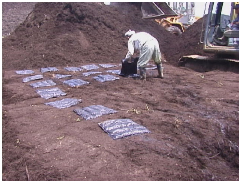
写真－Ⅱ． 2． 2 パイル断面に並べた吸着マットを被覆する様子
