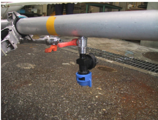
写真5 ノズルの取り付け状況
