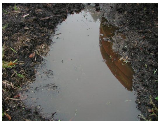
写真－VI. 2. 4 パイ ル周辺の水溜り
