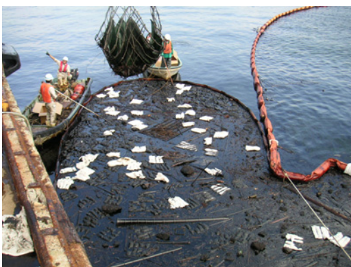
写真－VI. 1. 5 オイルフェンスで包囲された油を回収する様子
