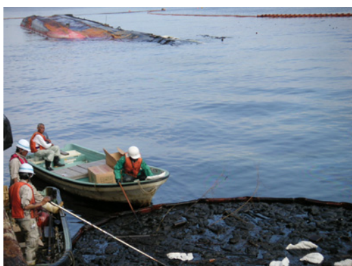
オイルフェンスで囲った中での 杉樹皮製吸着材による油の回収 平成 16 年 9 月 広島県廿日市市木材港岸壁
