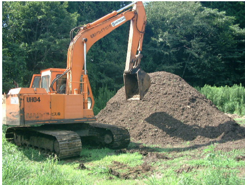
写真－Ⅱ． 2． 3 パイルの攪拌の様子
