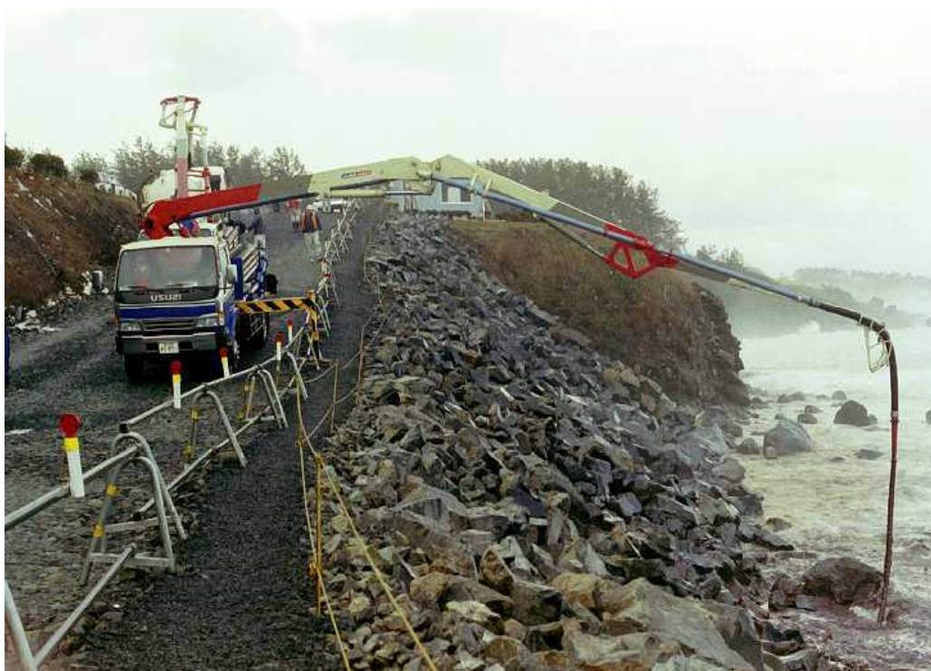
写真6 コンクリートポンプ車の例 (ナホトカ号事故)
