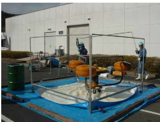
写真12 飛散防止シート用 フレーム設置
