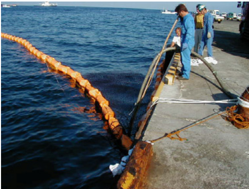
平成14年11月 伊豆大島波浮港での オイルフェンスの展張
