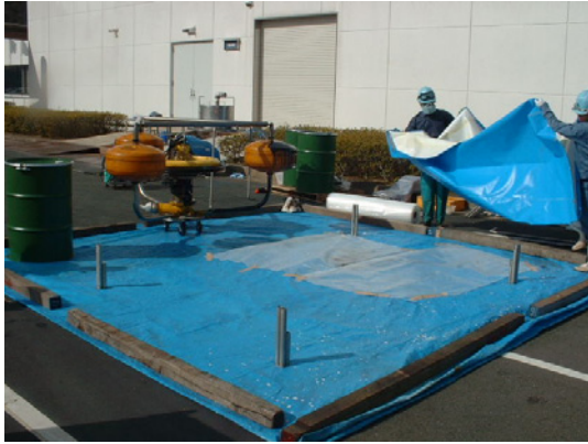
写真8 フレーム脚の設置
