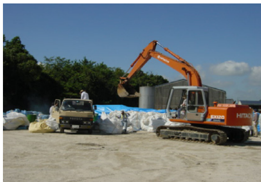
【写真 16】現場から搬入された回収物の荷下ろし
