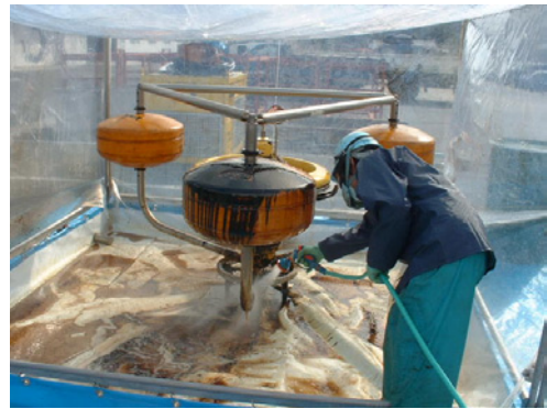
写真 27 灯油散布の状況
