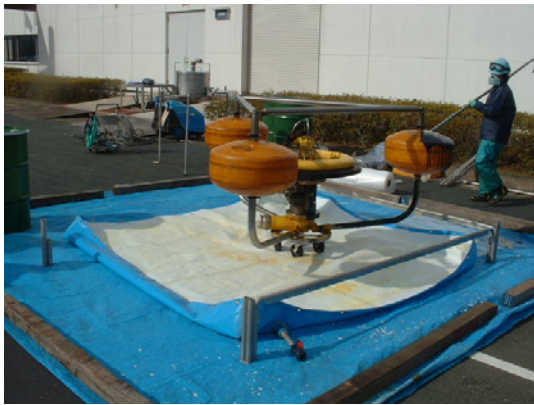
写真10 受皿フレームの設置
