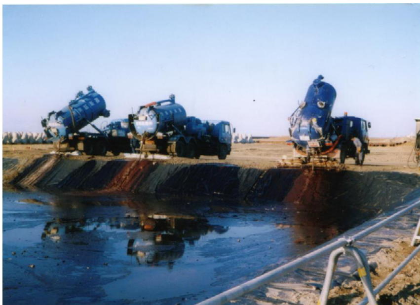
ナホトカ号で建設されたピット（福井新港 第1ピット）
