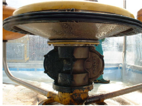
写真 25 スチーム洗浄後の状況 (左：ボンノック塗布、右：スチーム洗浄)
