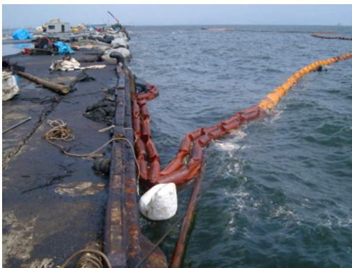
平成16年9月 広島県廿日市港での オイルフェンスの展張
