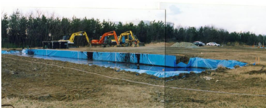
ナホトカ号事故の際に作られたピット（福井新港予備ピット） 長さ36m×幅6m×深さ2m、約400m 3 、
