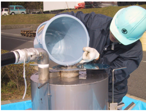
写真 16 灯油（洗油）の投入の状況
