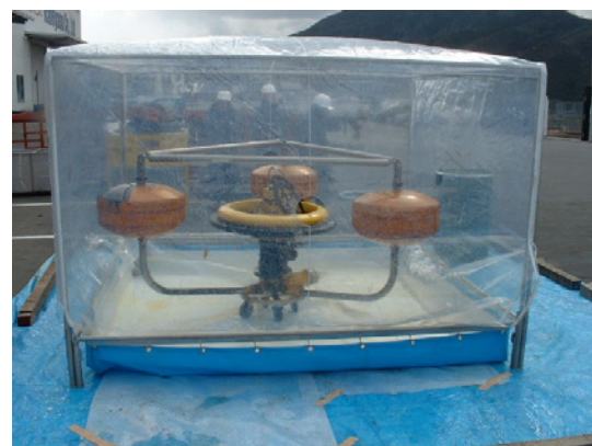
写真13 飛散防止シート設置
