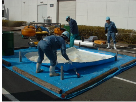
写真9 受皿シートの設置
