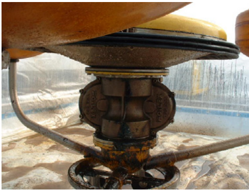
写真 26 高圧温水洗浄後の状況 (左：高圧温水洗浄、右：スチーム洗浄)
