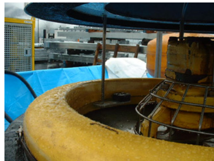
写真6 ホッパー持ち上げ用ハンドルの状況
