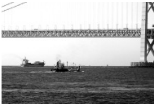
明石海峡大橋下の航路を通航する船舶
