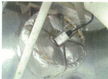
図 2.2.3 センサ取付け状況
