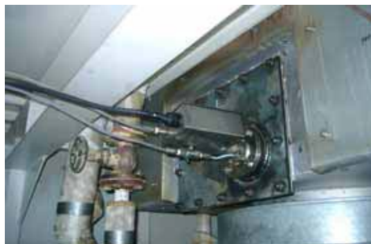
図 5.3.3.5 NO x ・O 2 センサ取付状態
