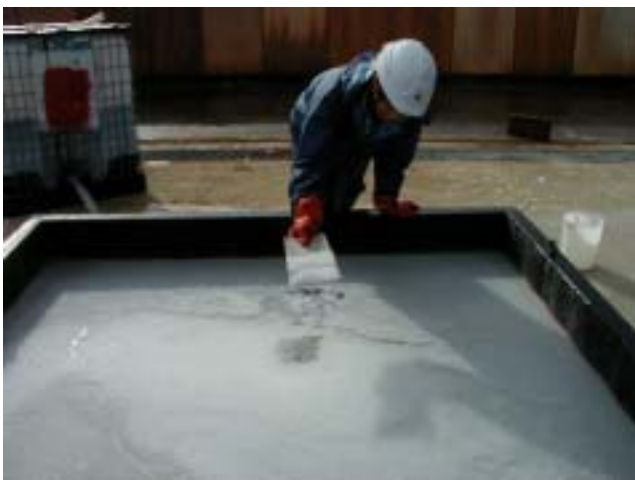
132 ポリマー固化状況
