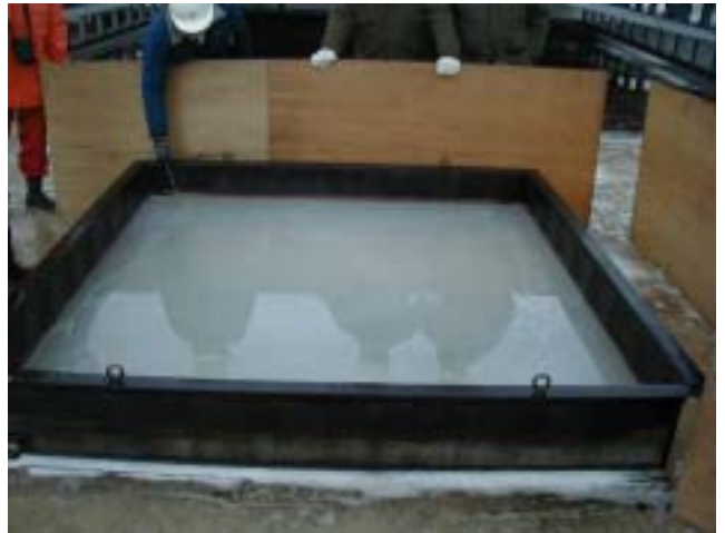
100 ポリマー 1 回目散布後
