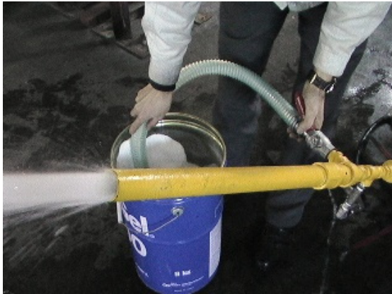
写真Ⅲ－１ ゲル化剤の吸引状況
