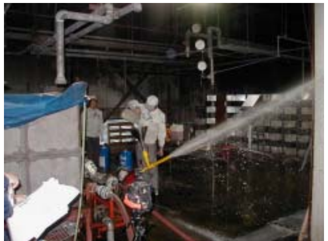
010 ゲル化剤のホッパーへの投入状況
