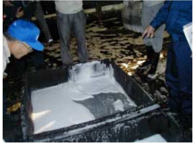
053 ゲル化の状況
