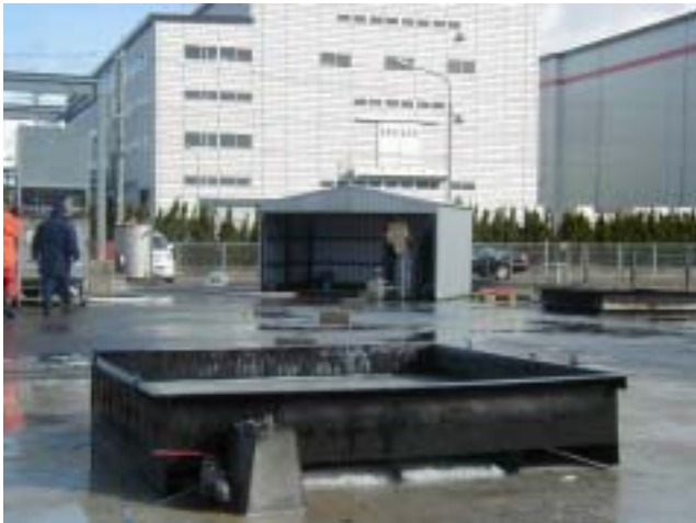
065 ゲル化剤散布後
