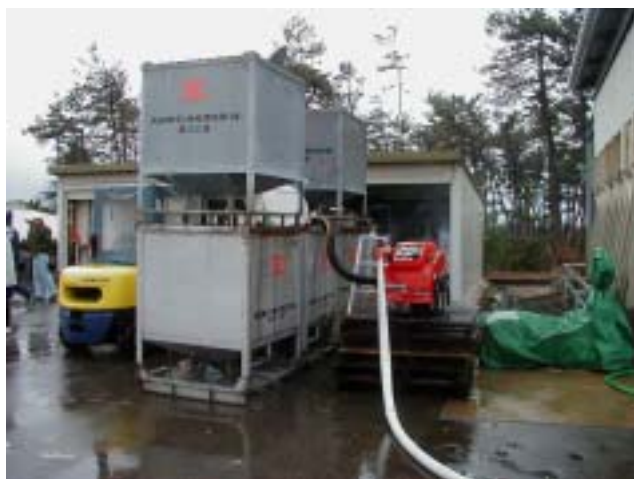
006 給水供給用ガソリンポンプ
