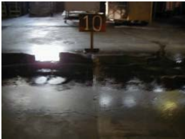
015 散布されたゲル化剤 (10m 付近)
