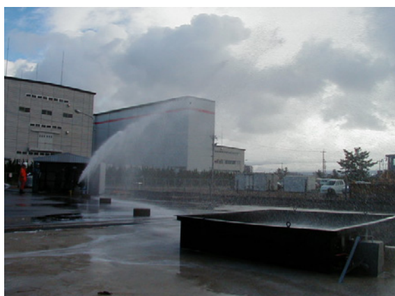
写真Ⅲ－23 ゲル化剤散布状況
