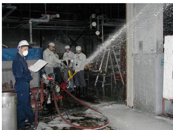
写真Ⅲ－9 散布装置と放水の状況
