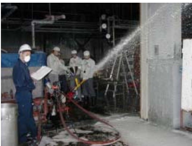
050 ゲル化剤及びゲル泡の散布 (1.9 m)
