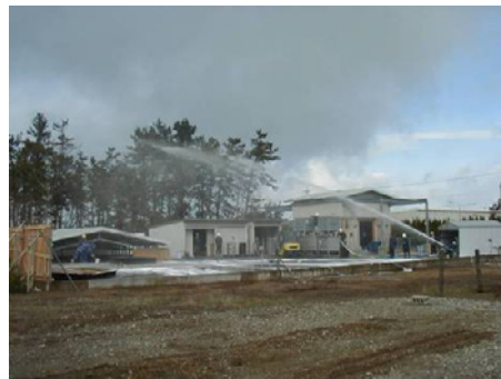
ポリマー散布状況
