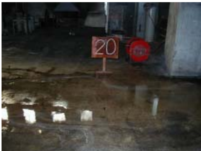
017 散布されたゲル化剤 (20m 付近)
