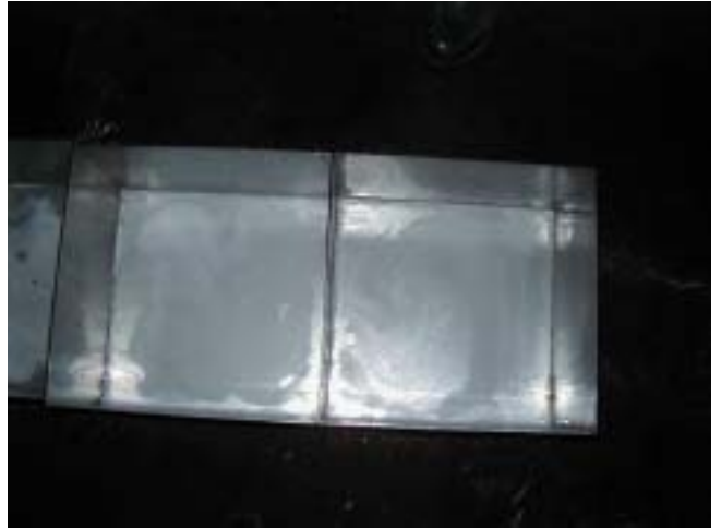
020 散布状況（15,20m の計量マス内部）
