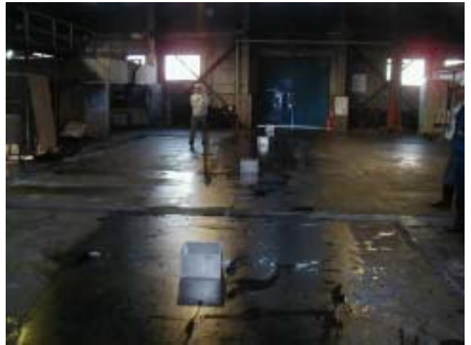
014 計量マスの設置の状況 (5m 付近)
