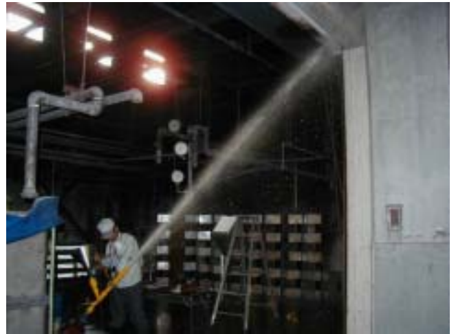
026 仰角 38 度での放水の状況
