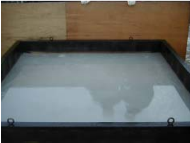
101 ポリマー 1 回目散布後
