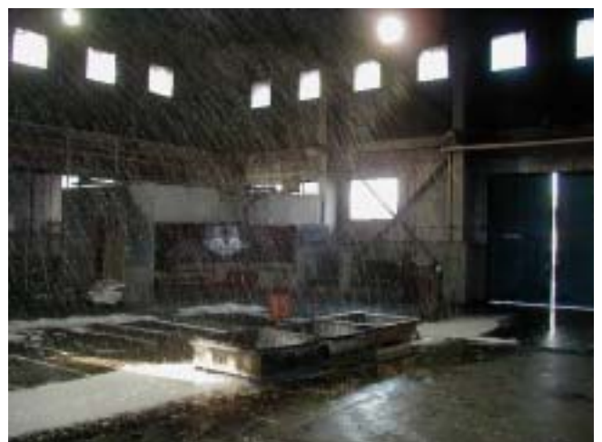
051 ゲル化剤及びゲル泡の散布 (1.9 m)
