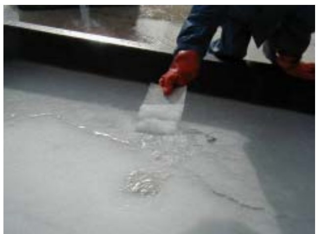
127 ポリマー固化状況
