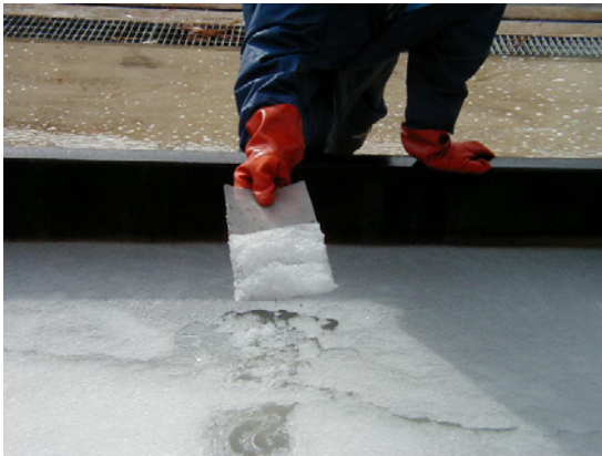
写真Ⅲ－２９ ポリマー追加散布後の固化状況
