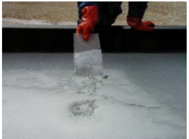
131 ポリマー固化状況
