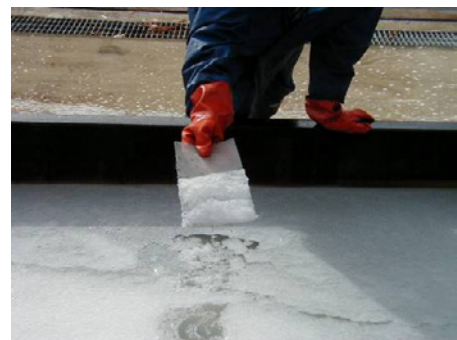
ポリマー固化状況
