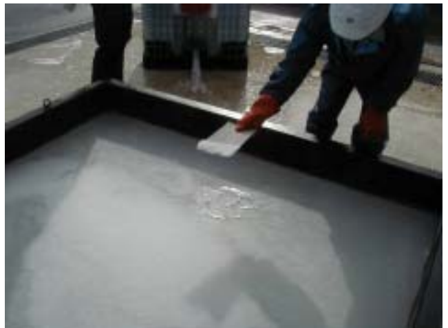
125 ポリマー固化状況
