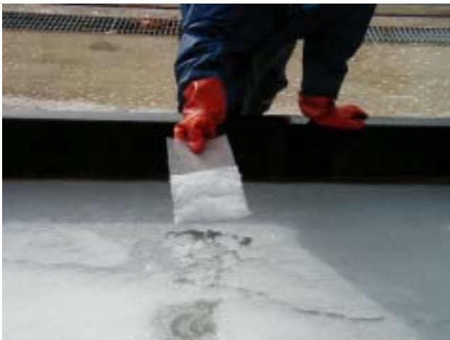
130 ポリマー固化状況
