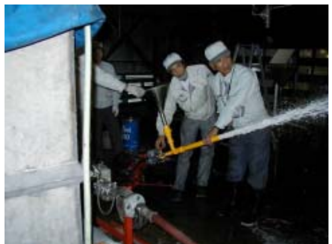
039 ゲル泡（6%型）の1%混合放水 （1.9m）
