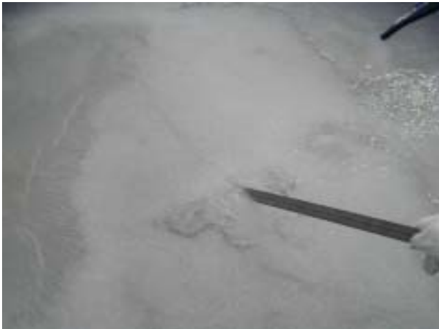
134 ポリマー固化状況
