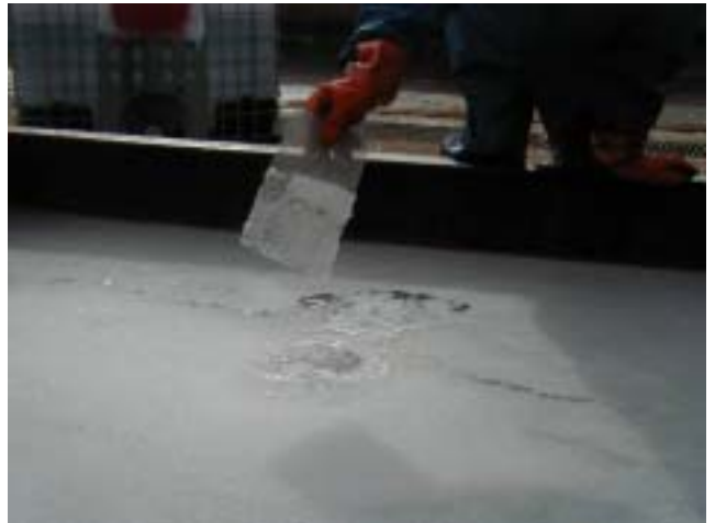
129 ポリマー固化状況
