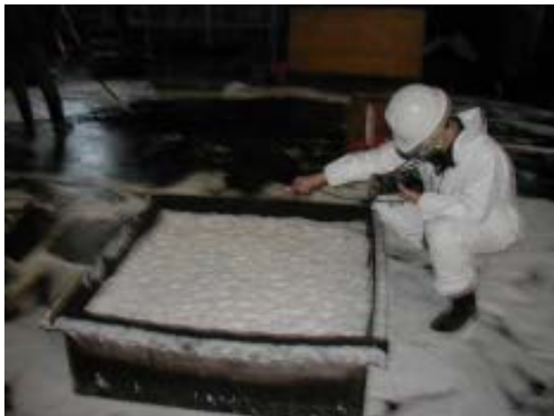
033 ベーパー濃度検知の状況
