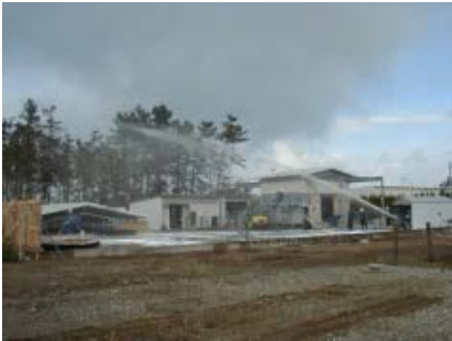
099 ポリマー 1 回目散布 (25m)
