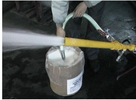
写真Ⅲ－２ ポリマーの吸引状況
