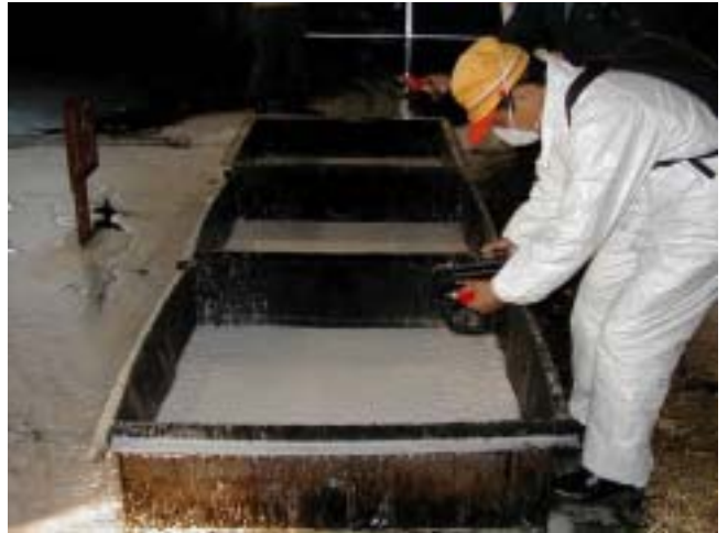
061 ベーパー濃度測定状況
