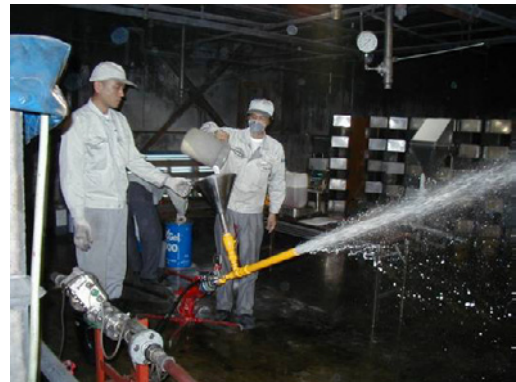
水+ゲル化剤の散布の状況
