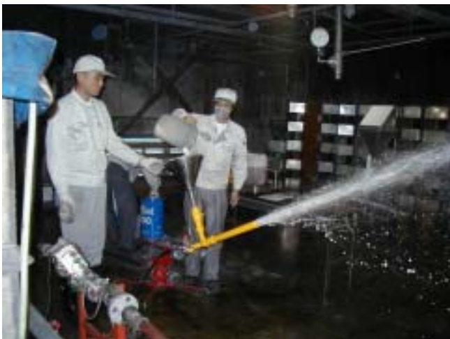
009 ゲル化剤のホッパーへの投入状況
