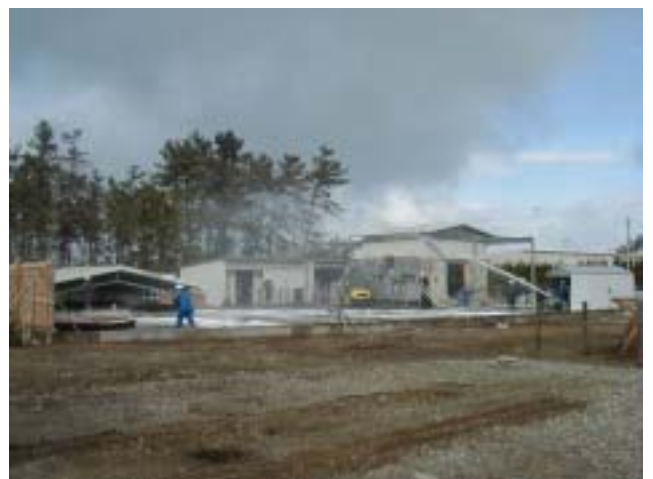
098 ポリマー 1回目散布 (25m)
