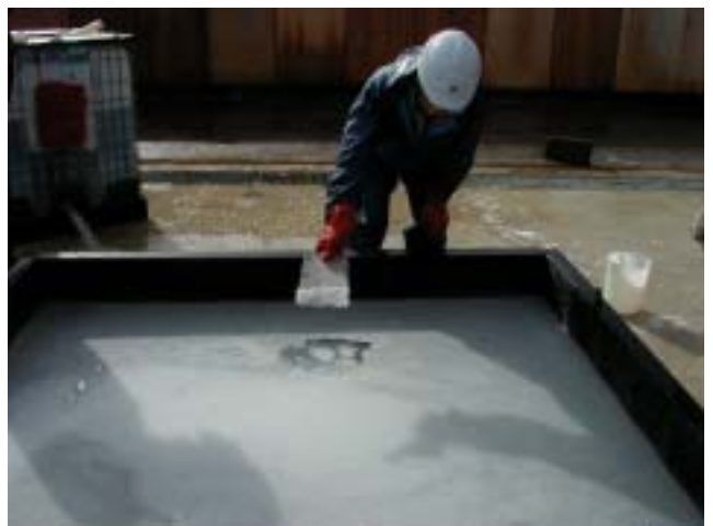
133 ポリマー固化状況
