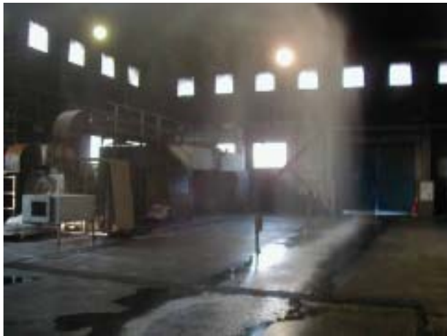
013 ゲル化剤散布の状況 (22m)
