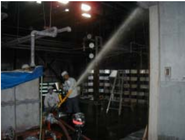
025 仰角 38 度での放水の状況
