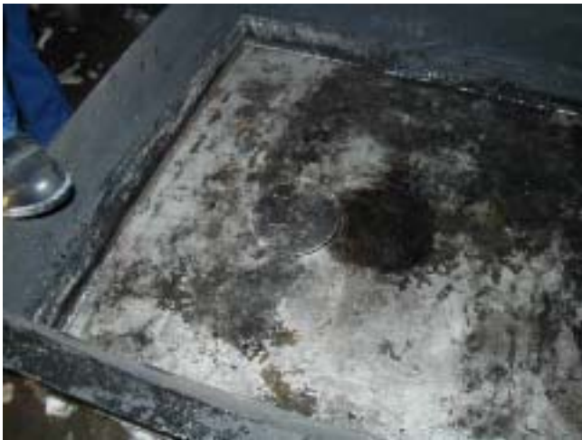
048 投入後のキシレンの状況
