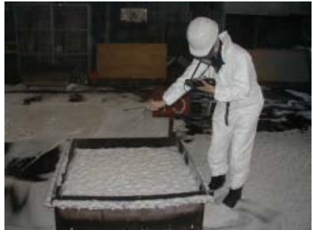
032 ベーパー濃度検知の状況
