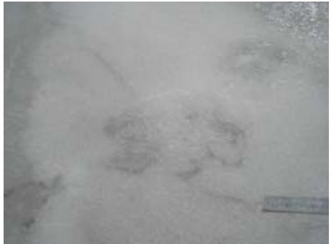
135 ポリマー固化状況
