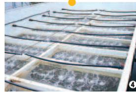
個のろ過ユニット(ろ過槽)からなる。ろ過ユニット1個は、1.5×3.6m<sup>2</sup>の断面積をもつ。ユニット内の好気性を保つために、ろ過層は海砂を上側に、それより水を通しやすい水砕スラグを下層とする2層構造とした。これにより、下層の水砕スラグ内には常に空気が存在する。
