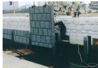
カニが好む石積み機能を再現したカニ護岸パネル
