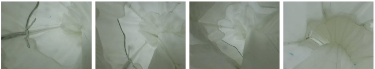
試験に使用したスパイラルシューターの中（下から上を見る）
