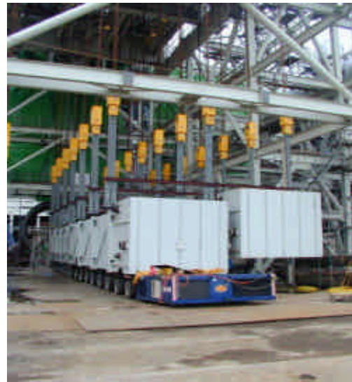
Fig 18: Lifting of prefabricated HRSG modules
