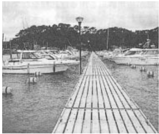
塩釜漁港（釜の淵）に作られたプレジャーボート棧橋
