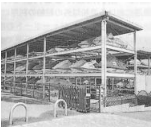
水上オートバイを収容する立体艇庫
