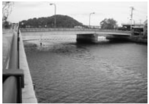
横浜市・侍従川。河口近くの橋の付近にフロートを常設し、プレジャーボートが出入りできないようにした。(H15・6・24撮影)
