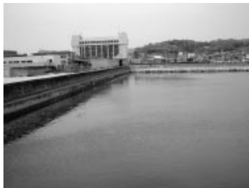
児島港 かやかり 地区の簡易係留施設予定港区
