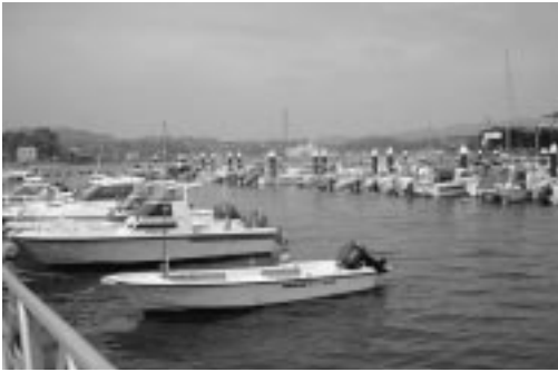
水島港乙島西地区の簡易浮桟橋の係留施設
