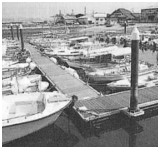
桟橋が設置されたばかりの地御前漁港のボート桟橋
