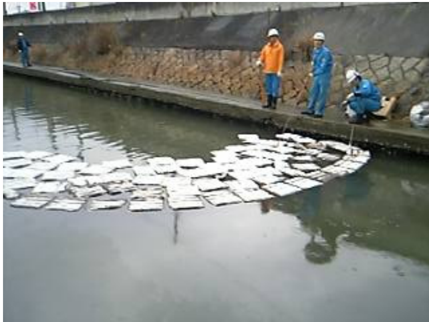
写真-IV. 2. 3 杉樹皮製油吸着材の使用の様子
