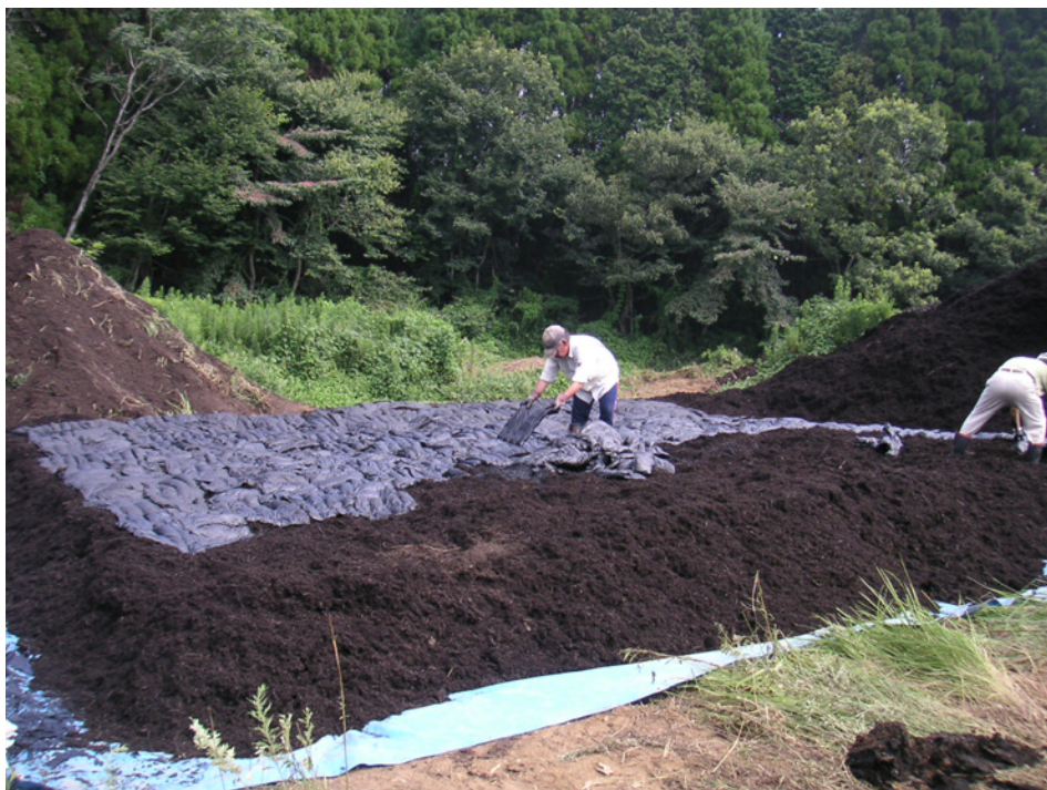
写真－Ⅱ． 2． 2 パイル断面に吸着マットを並べる様子
