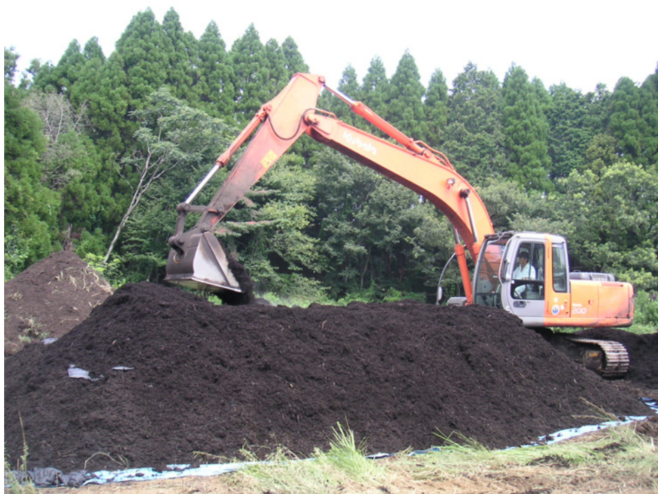
写真－Ⅱ． 2． 3 パイル断面に並べた吸着マットを被覆する様子
