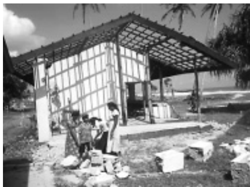
津波でブロック塀や壁が壊れた漁業協同組合。
