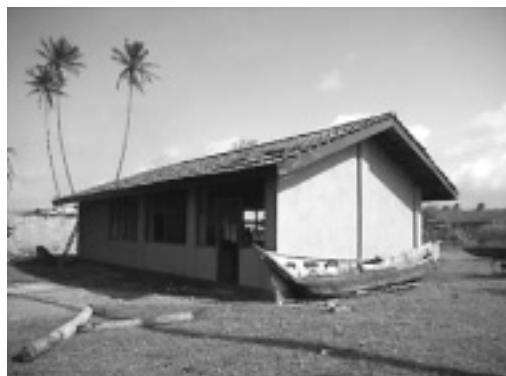
関係者全員の協力で修復された漁業協同組合。
