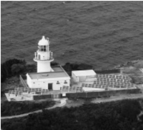
航路標識用電源として国内最大の太陽電池装置を有する草垣島灯台
