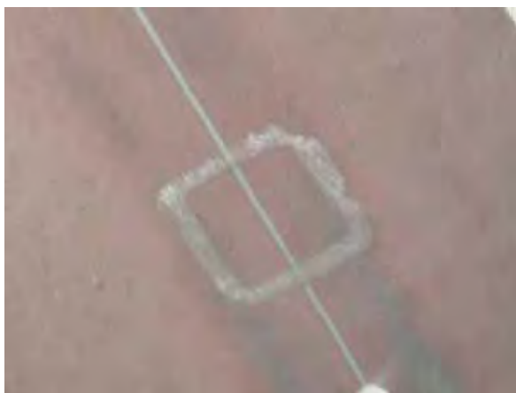
写真 4.1.1-3 パッチの剥がれ跡
