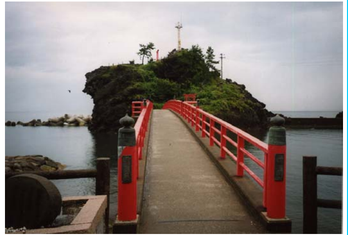
昭和 60 年 4 月完成 あけぼの橋
