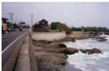
瀬戸浜北端の国道と直立護岸および沖合の岩礁
