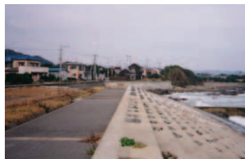
大きく前出しされた土地の海側を覆う緩傾斜護岸
