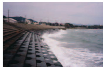
緩傾斜護岸の表のり面での砕波状況
