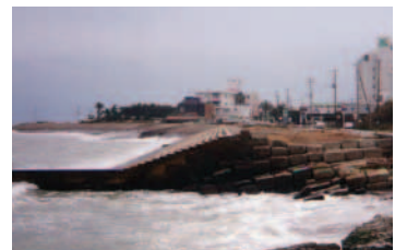
直立護岸上から緩傾斜護岸の端部を望む
