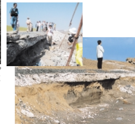
現在の野手海岸では同様の浜崖が見られる。このように九十九里北部では、依然として侵食が進行していることを示している。
