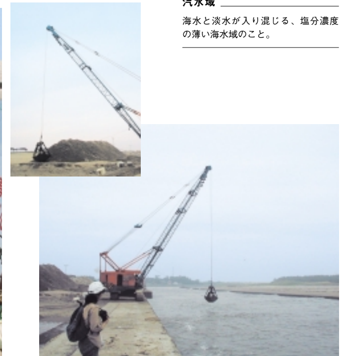
栗山川河口での浚渫作業
