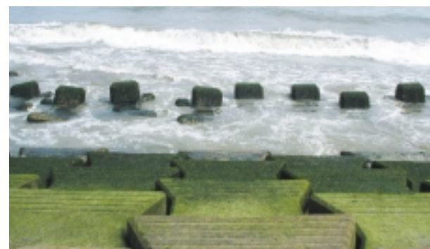
新川河口の北側には、緩傾斜堤が設置されている。水際は海苔などの生物付着で滑りやすく、親水性とは程遠い危険な状態である。
