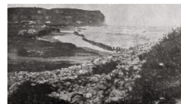
1949年(昭和24年)頃の護岸の状況
