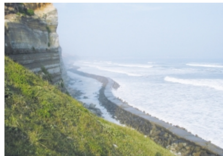
東洋のドーバーと呼ばれる屏風ヶ浦の海食崖。砂岩質のため岩そのものが非常に脆く、侵食が進みやすい。消波堤の設置によって侵食は抑えられている。
