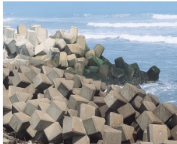
次から次へと新しく積まれた消波ブロック
