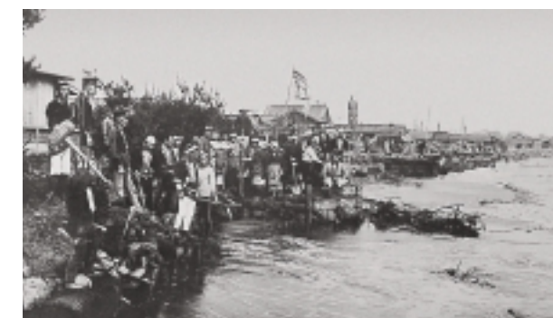
1933年(昭和8年)頃の海岸欠壊状況
