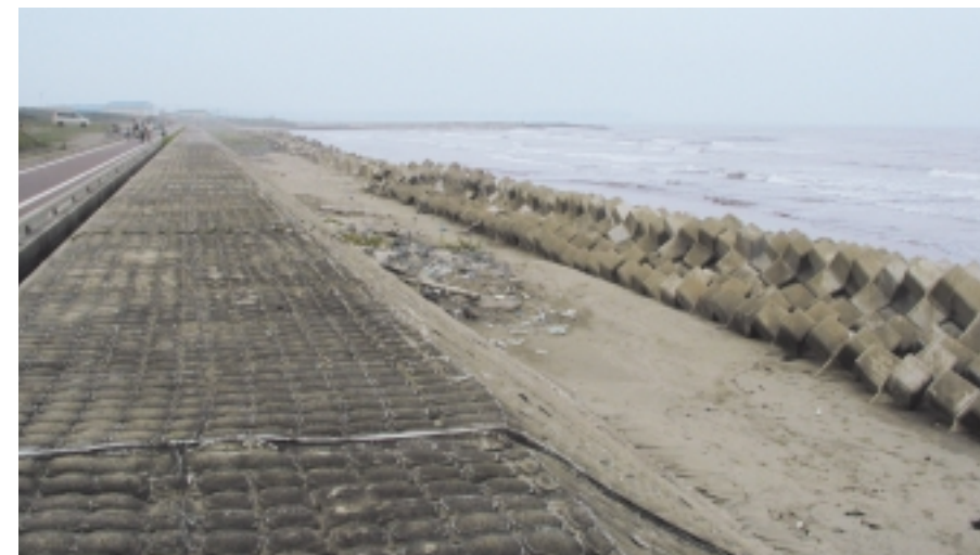
完全に護岸で固められ、全く砂浜が無くなってしまった2013年(平成25年)現在の吉崎海岸。さらなる侵食を食い止めるために、ヘッドランドが設置されている。
