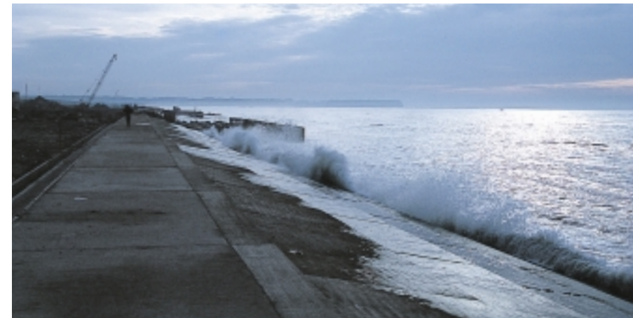
すでに飯岡付近で顕著だった海岸侵食は徐々に南へと伝播し、吉崎海岸も砂浜が削り取られた。写真は侵食対策のための護岸工事が開始された1980年(昭和55年)頃の光景。
