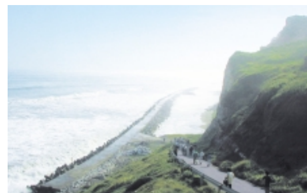
海食崖に沿って伸びる消波堤 崖には工事車両が下りるための坂道が数箇所設置されている。
