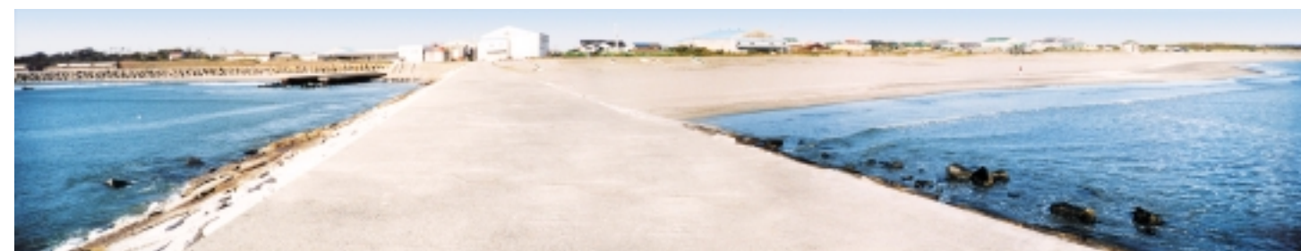
ヘッドランドのパノラマ ヘッドランド左右の砂のつき方(椎名内海岸)。ヘッドランドの右側には広い砂浜が形成されているが、左側には見られない。このようにヘッドランドには砂をとどめる効果があるのは事実だが、砂浜を維持する漂砂の絶対量が不足している現在では、もはやかつての広い砂浜の回復は望むべくもない。(2001年11月)
