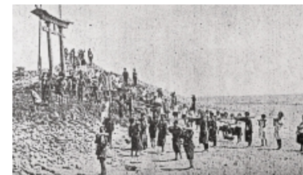
1931年(昭和6年)頃の小学生による波止を築く石積み風景
