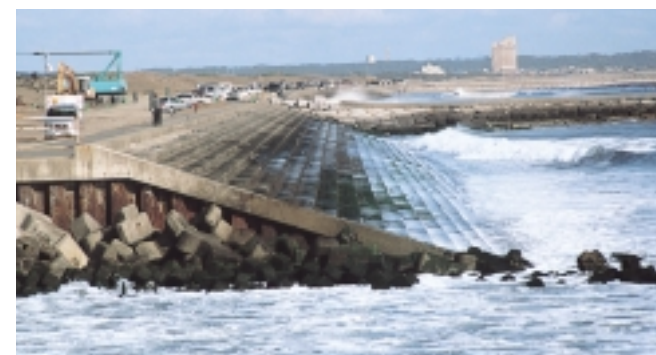
新川河口の北側には、緩傾斜堤が設置されている。水際は海苔などの生物付着で滑りやすく、親水性とは程遠い危険な状態である。
