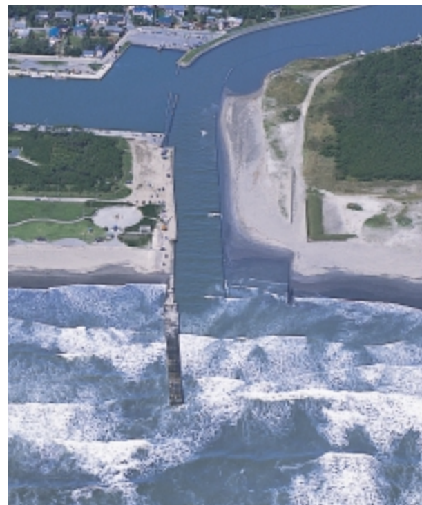
栗山川河口の3本の導流堤のうち、右側半分は砂に埋もれてしまっている。
