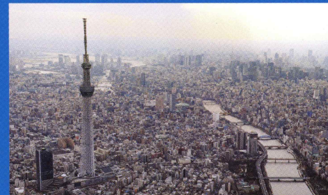
■世界一高い電波塔の東京スカイツリー(634m)開業
